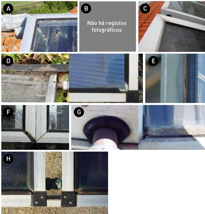
**Fig. 3** - Registos da degradação observada nos componentes elastoméricos (vedantes, juntas e passa-tubos).
