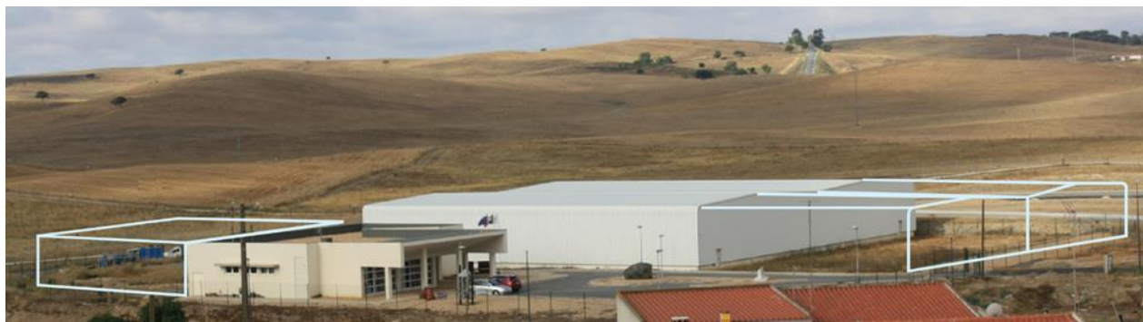
Áreas de expansão das infraestruturas (Edifício de Apoio, esq.) e Litoteca (dir.).
